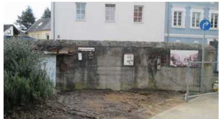
Ausgangszustand vor Beginn der Arbeiten am Kräutergarten
